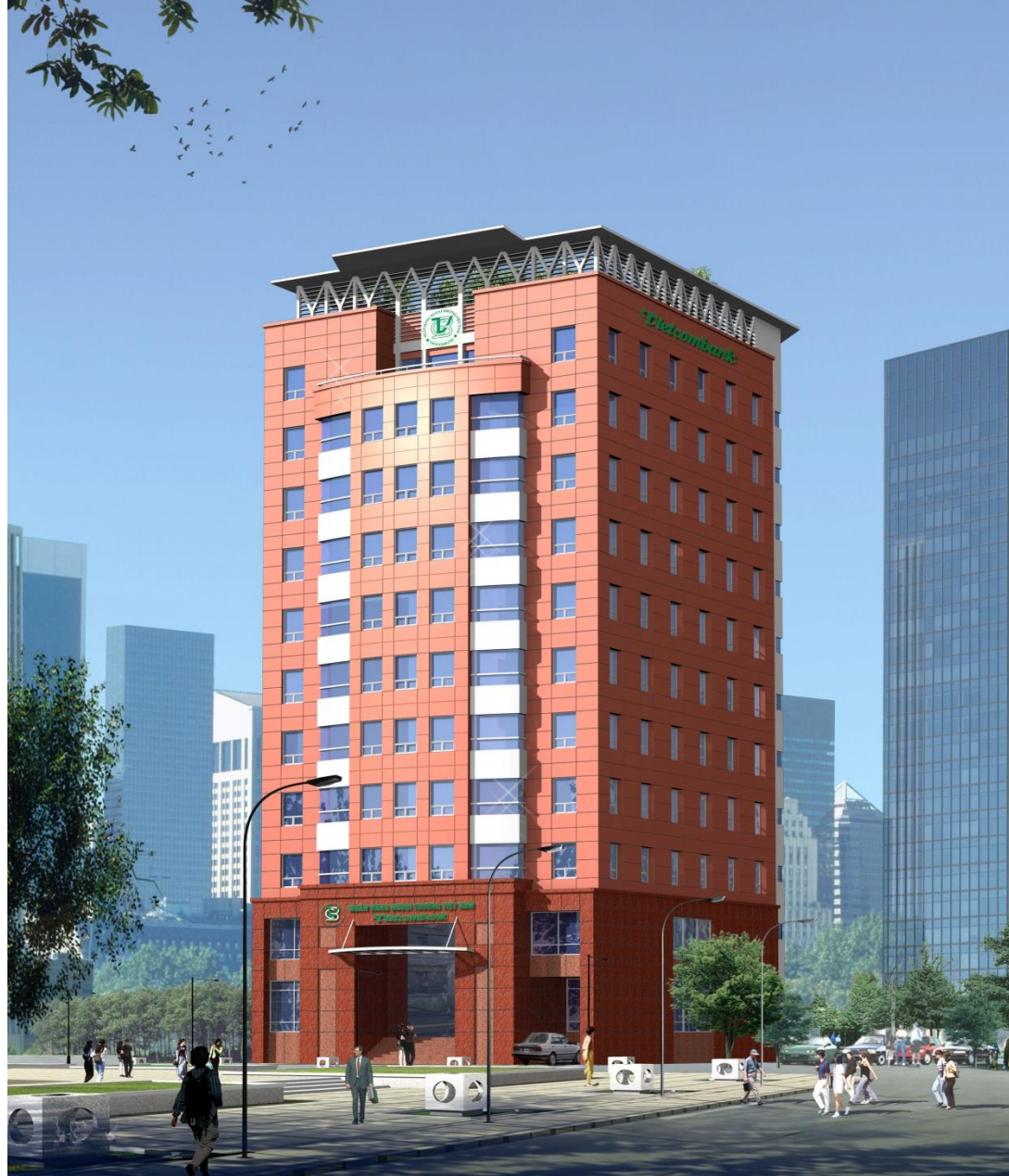
Trụ sở Ngân hàng Vietcombank – Chi nhánh Nha Trang| Vietcombank Nha Trang Nha Trang – Khánh Hòa | Nha Trang – Khanh Hoa 2007 | CĐT: Vietcombank | 11 tầng nổi + 1 tầng hầm; 6.600m 2 sàn 2007 | The Owner: Vietcombank | 11F + 1B; GFA: 6,600m 2 m 2
